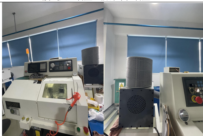
废气处理装置（油污净化装置2）
