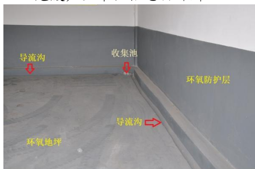
危废仓库地面防腐防渗措施、泄漏收集系统、管理台账记录
