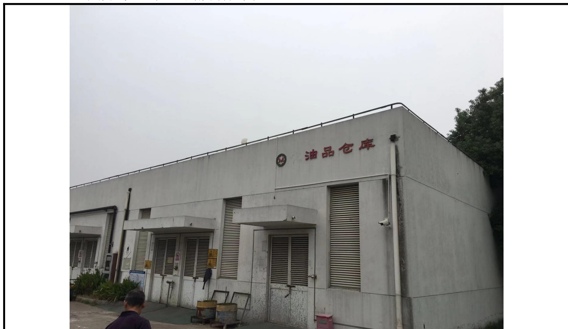
危废贮存场所
