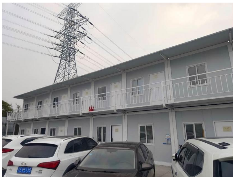
图 1-1 玖心（苏州）房地产开发有限公司现场事务所房屋
