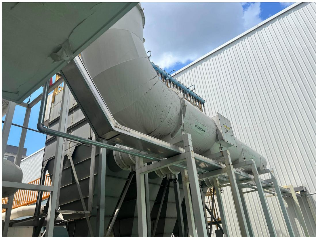
DA006 排气筒进口弯管较多，不符合采样条件
