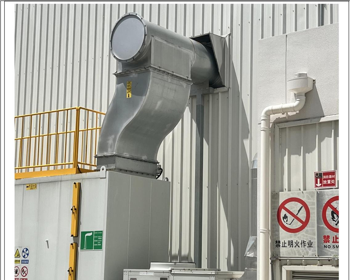
DA010 排气筒排气筒进口弯管较多，不符合采样条件
