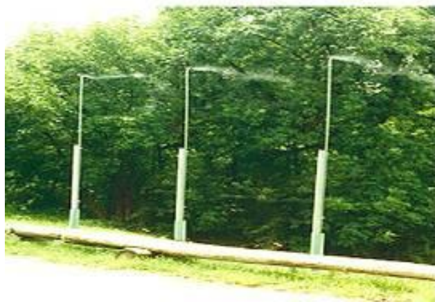
图 7.2-5 植物提取液喷淋装置图
