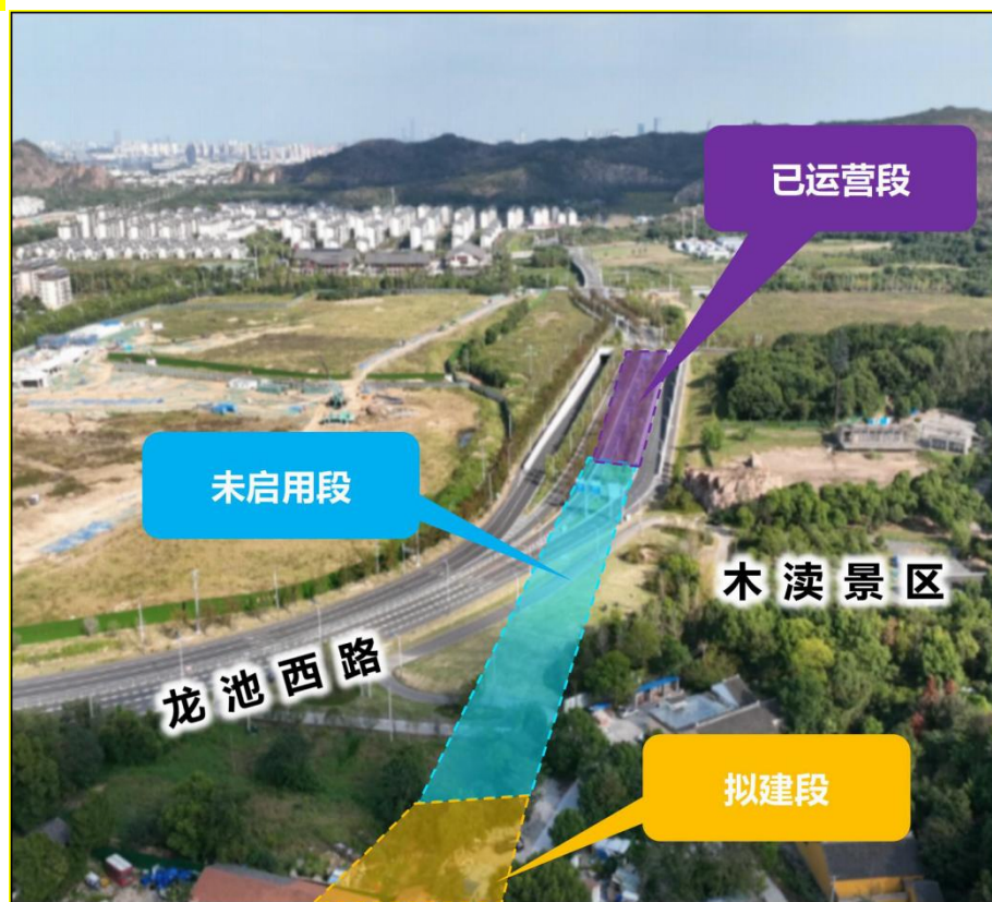
图 3.2-2 何山路西延已建段终点航拍图
