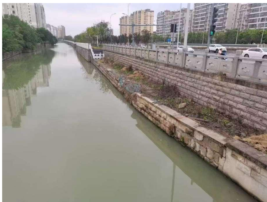
图 3-3 大寨河破损挡墙拆建段现状图
