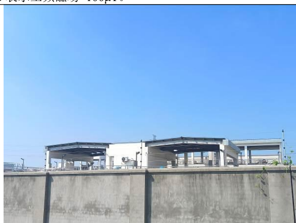
图 1-2 江苏中法水务有限公司房屋
