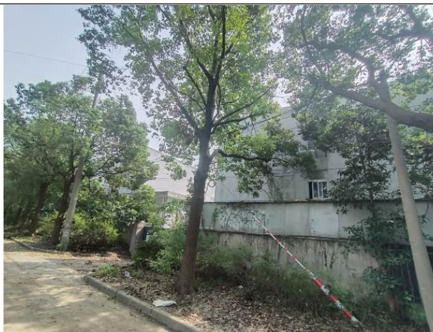
图2-2 沙洞路和浦发路交叉口西侧厂房
