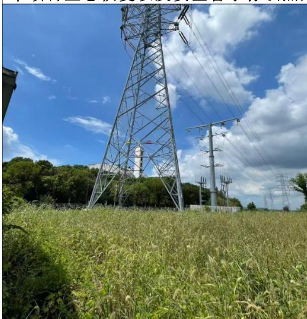
新建220熟练线同塔双回架空线路段 沿线生态恢复现状
