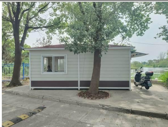
图2-3 常熟市南湖生活垃圾填埋场门卫室
