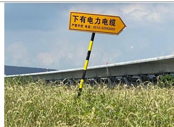
110练洞线地理电缆沿线生态恢复现 状
