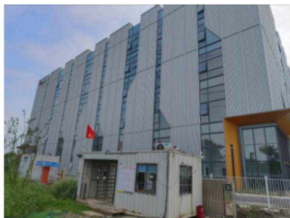
图 1-1 创智高端制造产业园一期房屋
