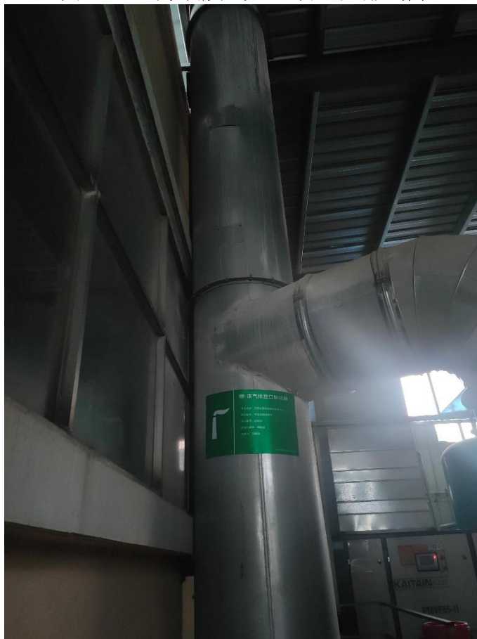
图 3.2-4 干压成型废气处理装置及排气筒
