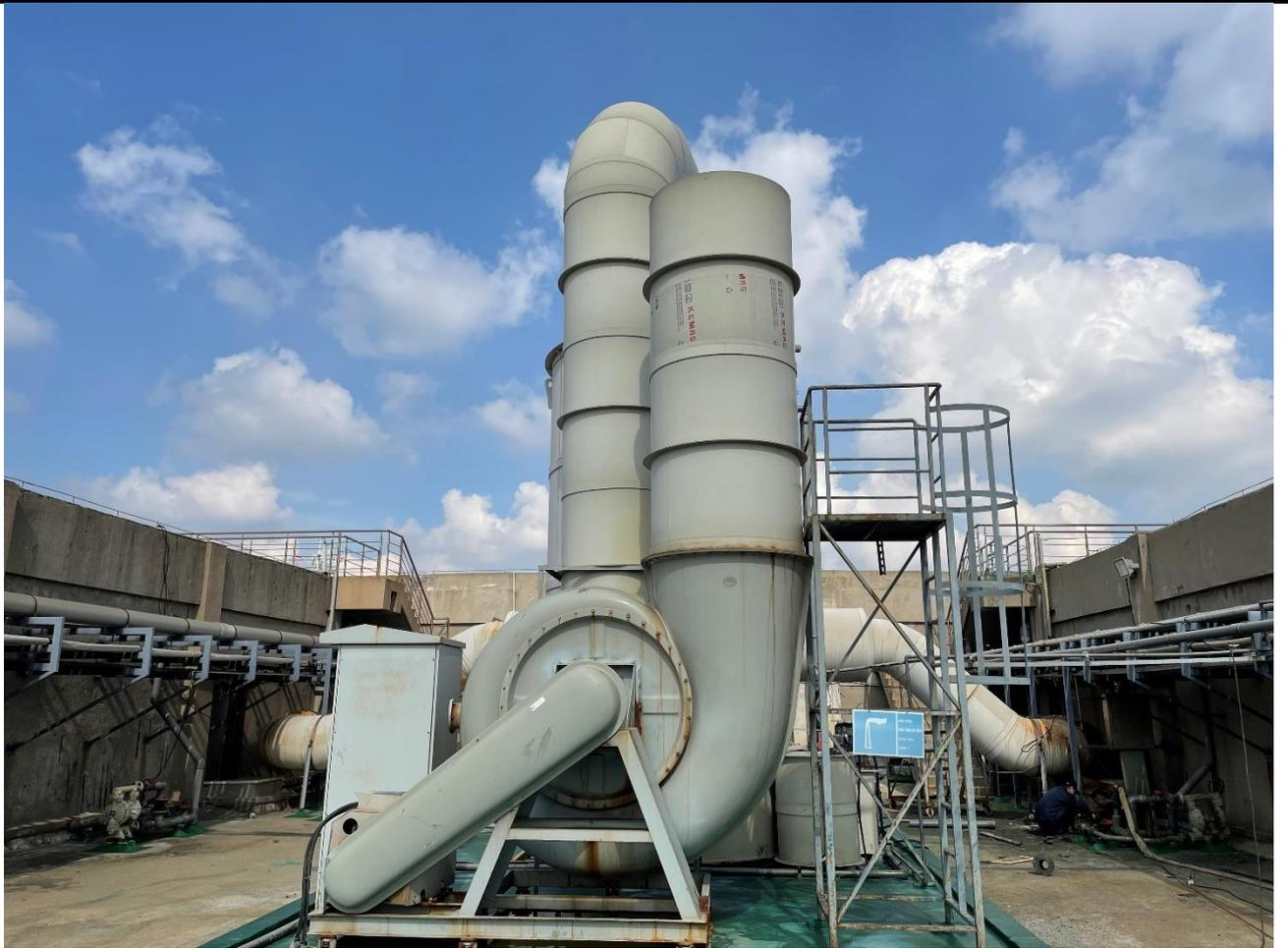
图 3.2-3 废气处理设施及排气筒
