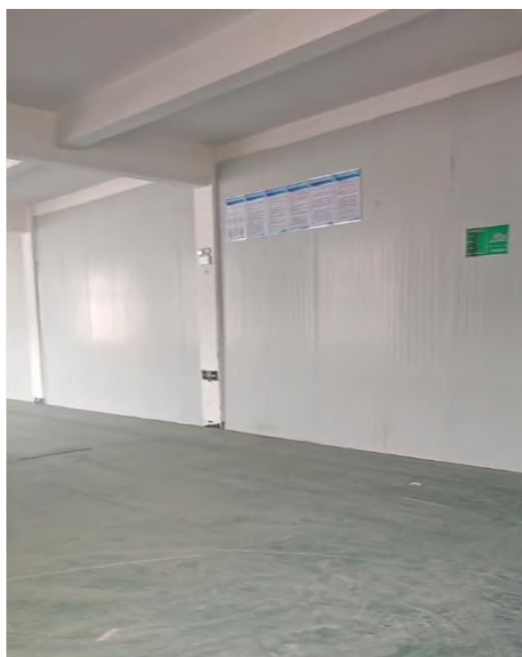
一般固废贮存设施
