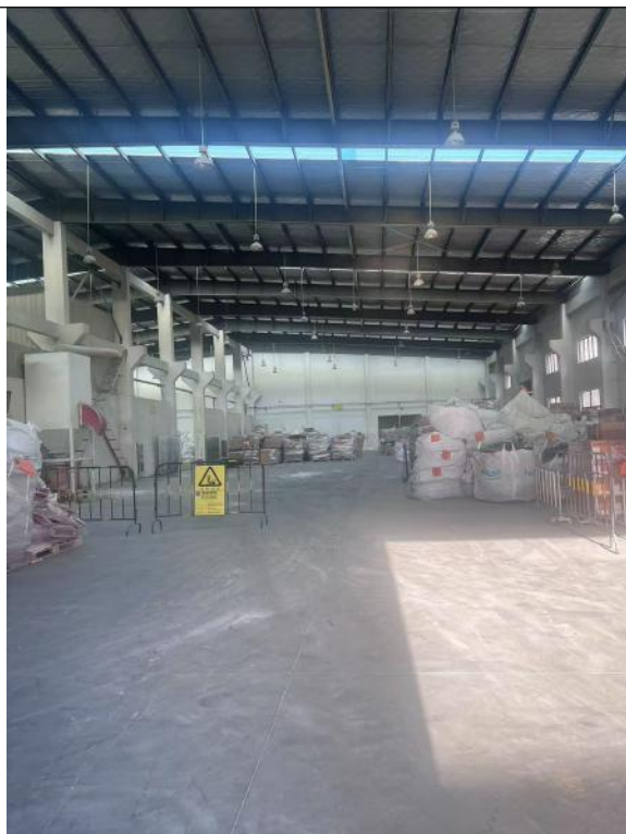
危险废物贮存设施
