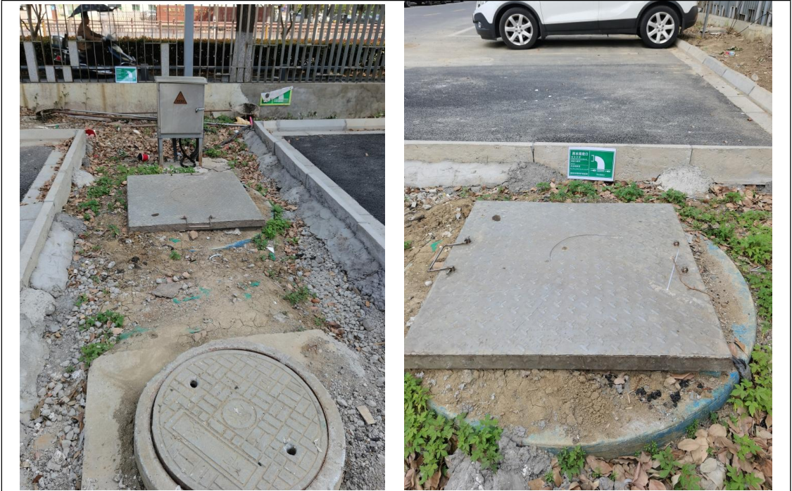
图 3-1 雨污水排口照片
