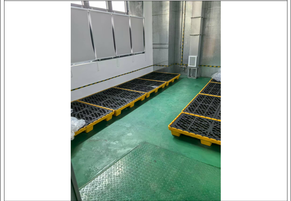
危废仓库内部
