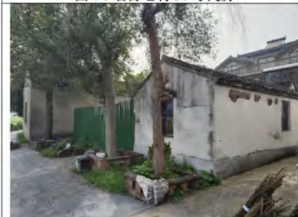
图 1-5 尹家浜村东南侧民房
