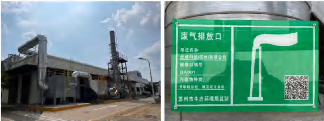
图 3-2 二级活性炭装置（TA001）+DA001 排气筒照片
