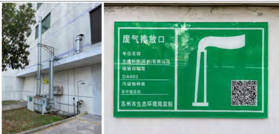
图 3-3 活性炭装置（TA002）+DA003 排气筒照片
