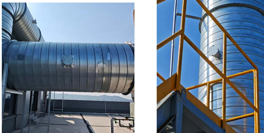
图 6-3 有组织废气监测点位实拍照片（左边进口、右边出口）
