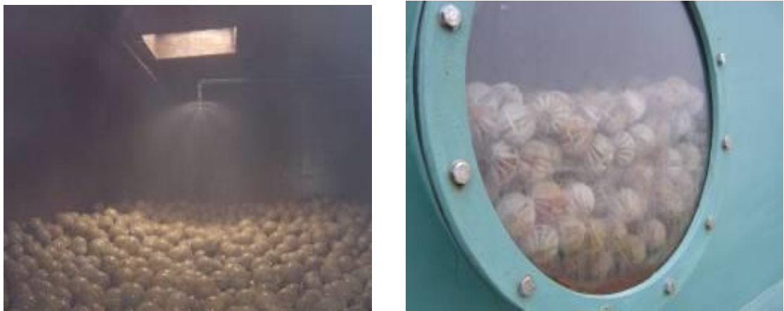
图 6.1-2 生物滤池填料示意图
