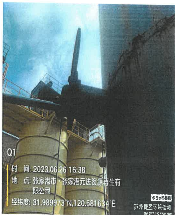
采样点位: 排气筒 1#出口 Q1
