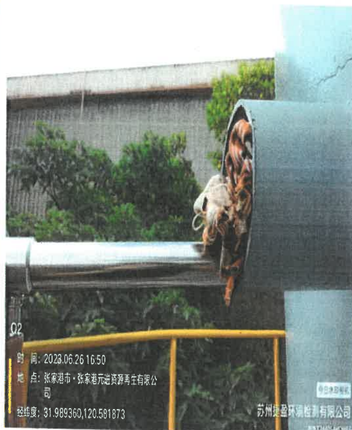
采样点位: 排气筒 2#出口 Q2
