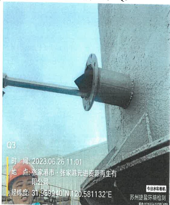
采样点位: 排气筒 3#出口 Q3
